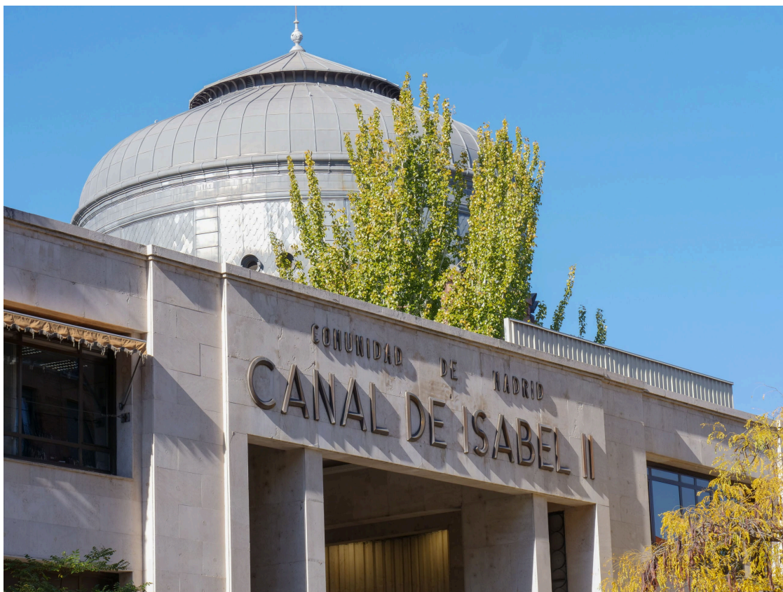
Oficinas centrales del Canal de Isabel II Comunidad de Madrid
